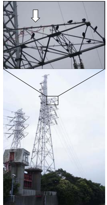
写真. 送電鉄塔のねぐら。カワウ避けのロープ(↓)が張られている。 [Photo by 箕輪義隆]
