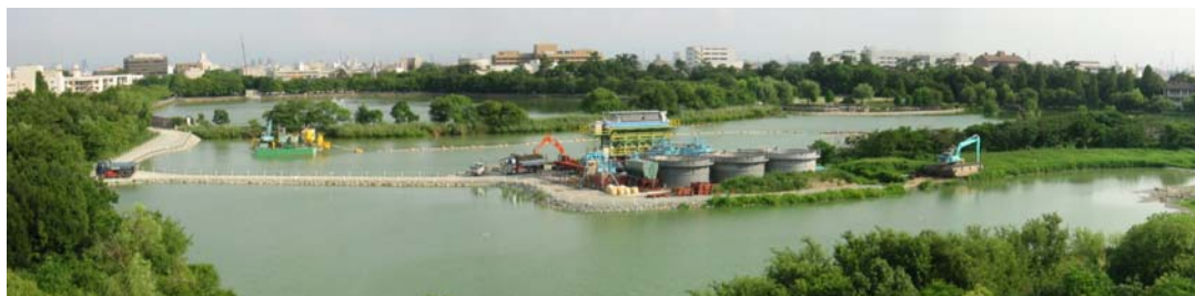
浚渫工事中の昆陽池公園
