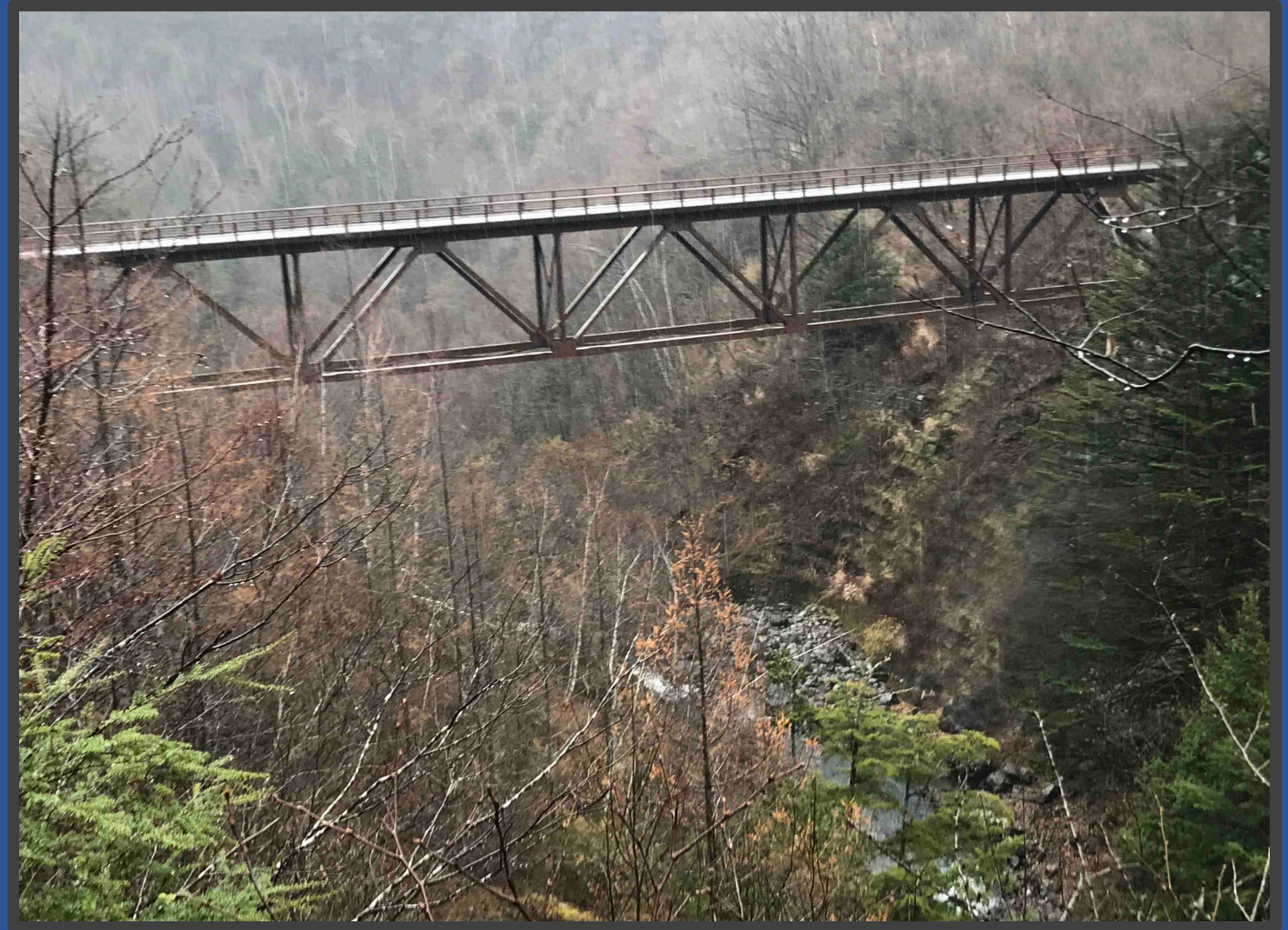
上流側から見た橋の全景（画像を一部加工処理）
