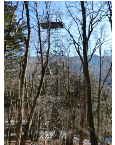
写真. マイクの設置してある鉄塔。
