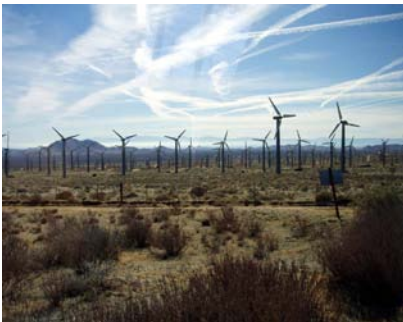
写真2. モハベの風力発電所。まだ風車による風の乱れについての知見が十分でない時期に建てられた発電所のためだということでしたが、高密度に風車が建てられており、圧倒されるような風景。アルタモントと違い土漠のような環境のためか、生物は少ない。
