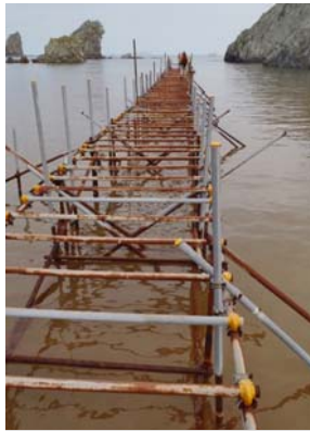
写真1. 媒島の湾。この骨組みだけの栈橋にポートをつけ、パイプの上を歩いて上陸する。
