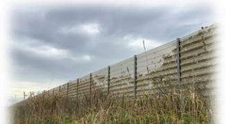
防風柵の設置
